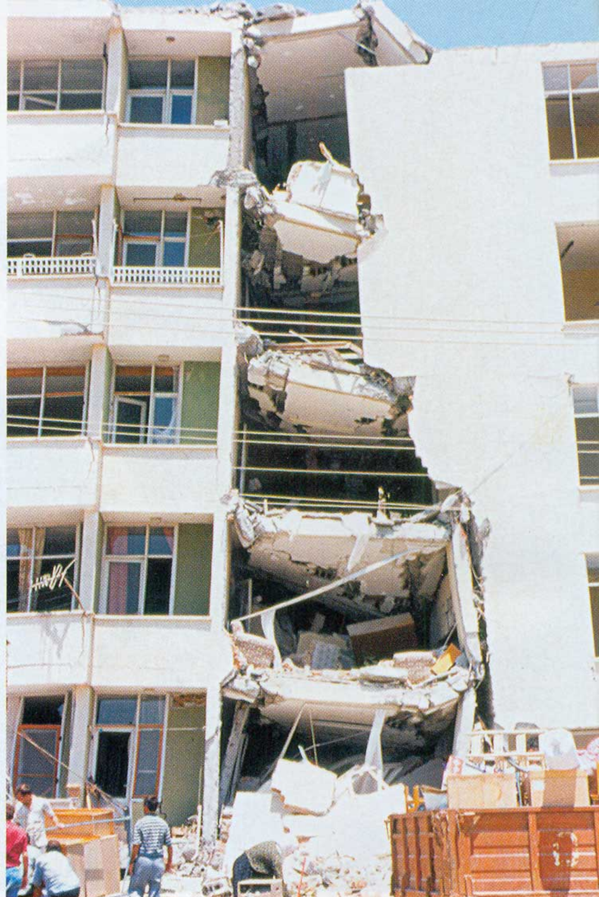
Ένα κτήριο που έπαθε σημαντικές βλάβες στο σεισμό των 6,2 R στα Αδανα της Τουρκίας το 1998. Αλλά τμήματά του συνθλίφθηκαν, άλλα έμειναν σχεδόν αλώβητα. Οι αντοχές των επιμέρους τμημάτων του έπαιξαν σημαντικό ρόλο για τις πιθανότητες επιβίωσης των ενοίκων του
