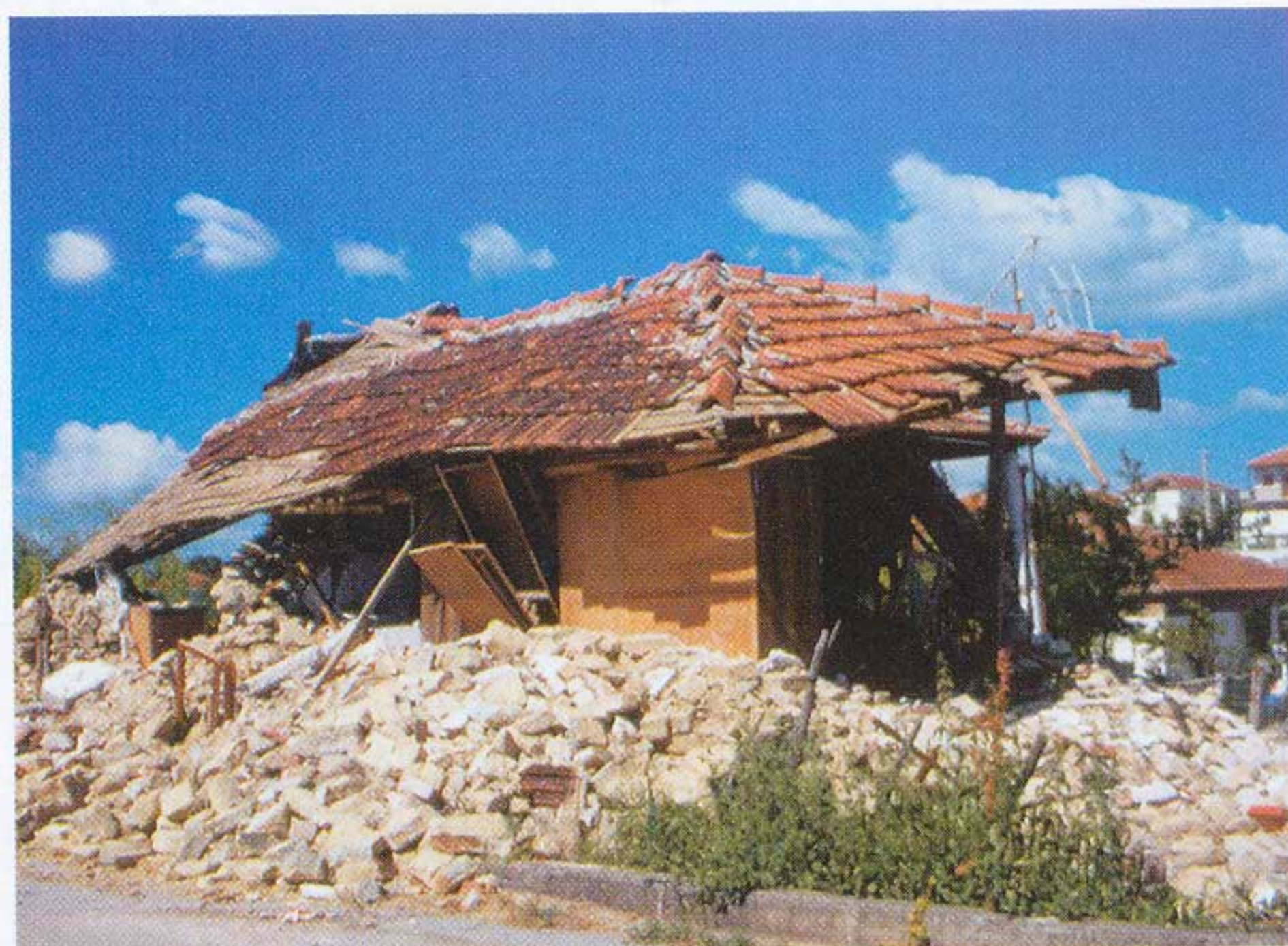
Σεισμός Γρεβενών, μεγέθους 6,1 R, 15 Μαΐου 1995. Η στέγη παρέμεινε στη θέση της στηριζόμενη σε μια ντουλίπα και πιο ειδικά σε μια βαλίτσα, πάνω στην ντουλίπα
