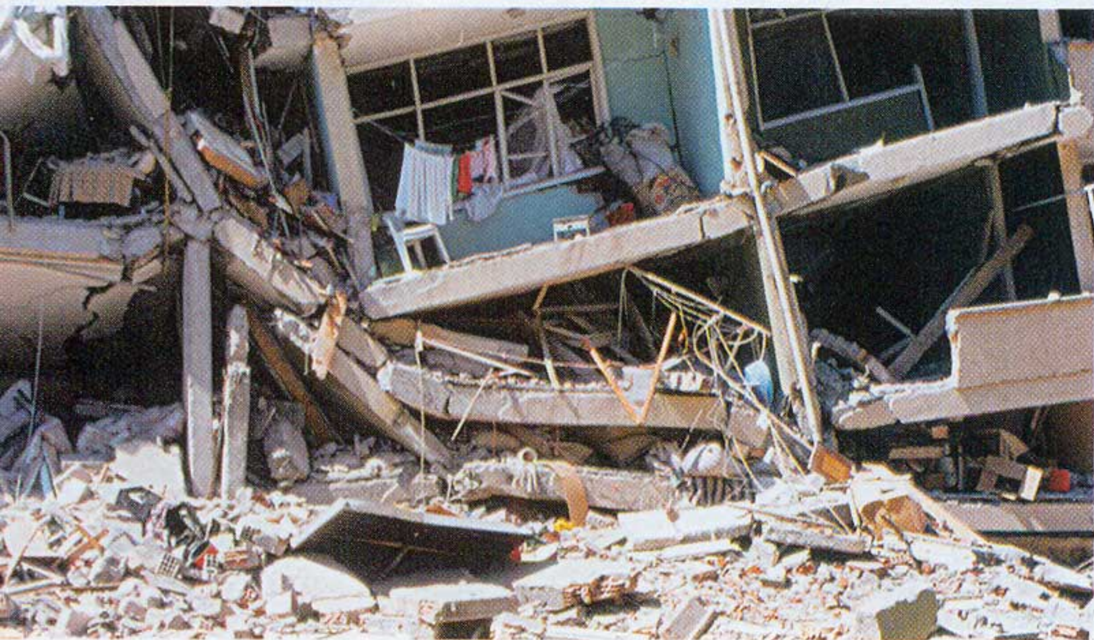
Ένα κτήριο που έπαθε σημαντικές βλάβες στο σεισμό των 6,2 R στα Αδανα της Τουρκίας το 1998. Αλλά τμήματά του συνθλίφθηκαν, άλλα έμειναν σχεδόν αλώβητα. Οι αντοχές των επιμέρους τμημάτων του έπαιξαν σημαντικό ρόλο για τις πιθανότητες επιβίωσης των ενοίκων του
