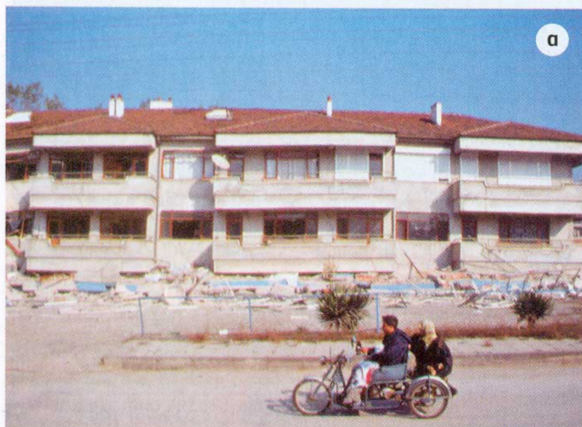
Στο πρώτο κτήριο η κατάρρευση άρχισε από το ισόγειο (α). Στο δεύτερο η κατάρρευση άρχισε από τους τελευταίους ορόφους (β). Και αυτά στον ίδιο σεισμό των 7,4 R του Izmit της Τουρκίας (Αύγουστος του 1999)
