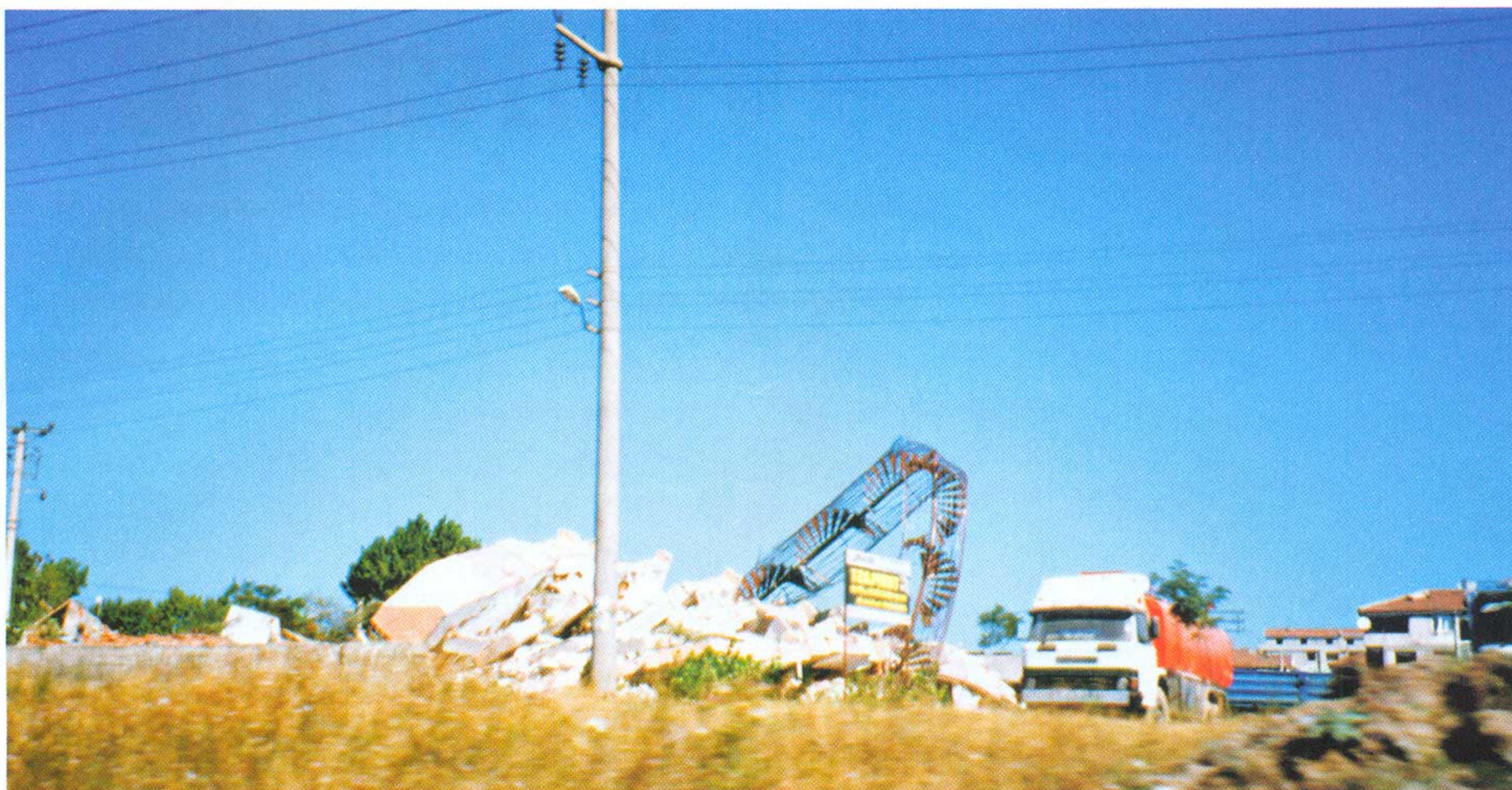
Το κτήριο κατέρρευσε αλλή η εξωτερική σιδερένια σκάλα το ακολούθησε με μια κάμψη, σαν να ήθελε να το κρατήσει όρθιο. Σεισμός Izmit Τουρκίας , μεγέθους 7,4 R, τον Αύγουστο του 1999
