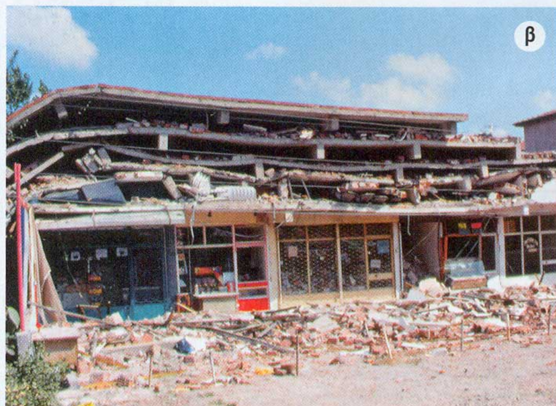
Στο πρώτο κτήριο η κατάρρευση άρχισε από το ισόγειο (α). Στο δεύτερο η κατάρρευση άρχισε από τους τελευταίους ορόφους (β). Και αυτά στον ίδιο σεισμό των 7,4 R του Izmit της Τουρκίας (Αύγουστος του 1999)
