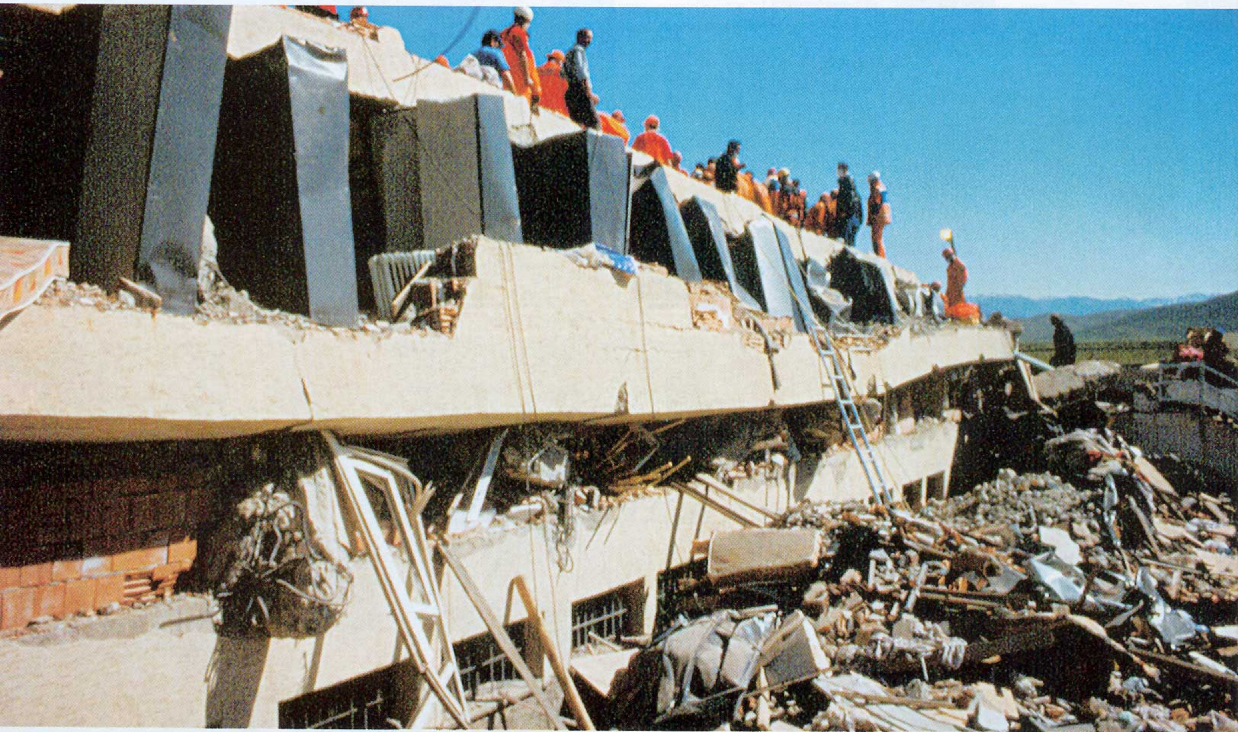
Το κτήριο του ορφανοτροφείου κατέρρευσε στην πόλη Bingol της ΝΑ Τουρκίας κατά το σεισμό των 6,4 R τον Μάιο του 2003. Η συστοιχία των μεταλλικών ντουλαπιών, όμως, στάθηκε ικανή να σταματήσει την πλάκα του 3ου ορόφου και να δημιουργήσει έτσι κενά στα οποία διασώθηκαν πολλά παιδιά
