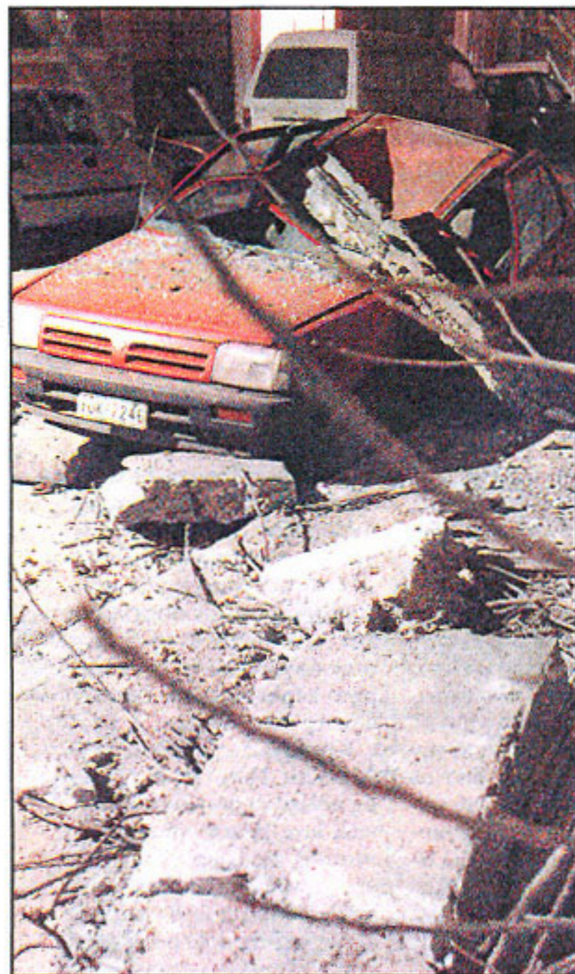
Πάνω σε ένα σταθμευμένο αυτοκίνητο κατέρρευσε το μπαλκόνι ενός εγκαταλελειμμένου κτιρίου
