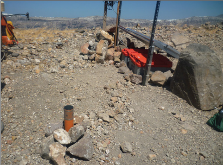
Εικόνα 23 Εγκατάσταση μόνιμου τηλεμετρικού σταθμού μέτρησης ροής CO 2 (Νέα Καμένη, θέση Αγ. Γεώργιος)
