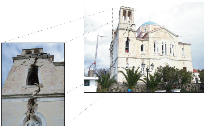
Σχήμα 3. Άποψη των βλαβών που υπέστη η μητροπολιτική εκκλησία στην πλατεία του χωριού. Η εκκλησία δεν υποστηρίζεται από κολώνες με οπλισμένο σκυρόδεμα αλλά είναι απλά κατασκευασμένη από πορώδη ασβεστολιθικά τεμάχια. Οι σημαντικότερες βλάβες παρατηρήθηκαν στα δυο καμπαναριά τα οποία όμως προστεθήκαν μετά την κατασκευή του κυρίως κτίσματος του ναού. Τα διαφορετικά ύψη και όγκοι των καμπαναριών σε σχέση με το κυρίως κτίριο οδήγησαν στις επικράτηση διαφορετικών ιδιοσυχνοτήτων κατά την ταλάντωση που οδήγησε στην αποκόλλησή τους από το κυρίως κτίσμα.
