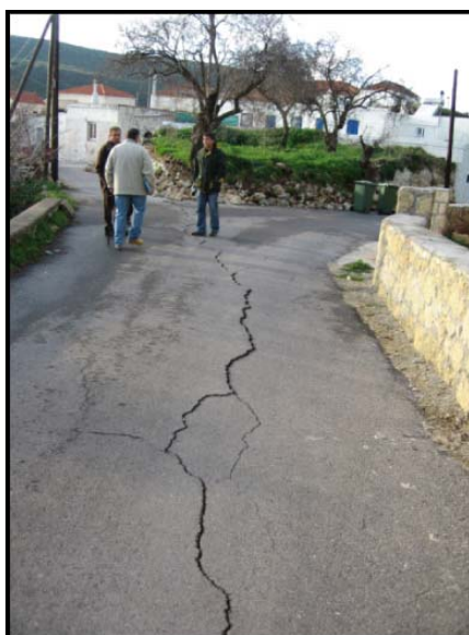
Σχήμα 8. Άποψη εδαφικών διαρρήξεων στον ασφαλτοτάπητα του χωριού.
