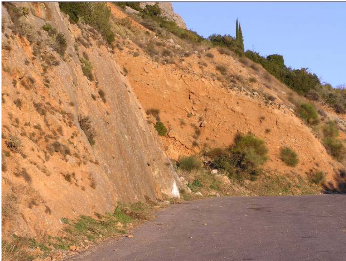
Σχήμα 3. Πλευρικά κορήματα που έχουν αναπτυχθεί στο κατερχόμενο τέμαχος κανονικού ρήγματος.
