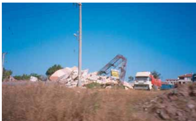
Εικ. 12 Εμφάνιση του σεισμικού ρήγματος του σεισμού της 17 ης Αυγούστου 1999 στην παράκτια περιοχή Golcuk που μετέθεσε δεξιόστροφα τη διάταξη των σιδερένιων στηλών κατά 5 μέτρα.
