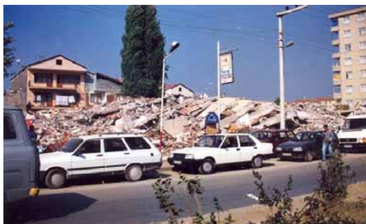
Εικ. 13 Κατάρρευση οικοδομών με κατεύθυνση παράλληλη προς τη διεύθυνση του ίχνους του ρήγματος οριζόντιας ολίσθησης που ενεργοποιήθηκε κατά το σεισμό της 17 ης Αυγούστου 1999.
