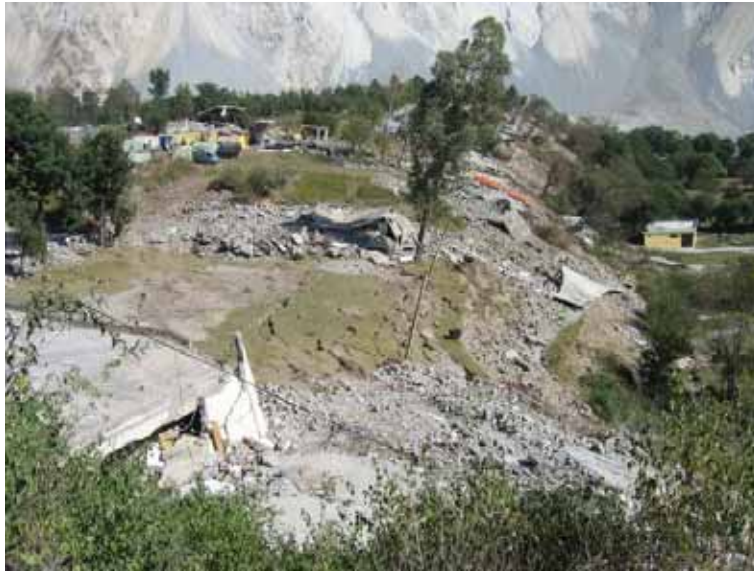
Εικ. 17 Κύρτωση του εδάφους και ολοκληρωτικές καταστροφές κατασκευών κατά μήκος του ανάστροφου ρήγματος και της πτυχωσιγενούς ολίσθησης κατά το σεισμό της 8 ης Οκτωβρίου 2005.
