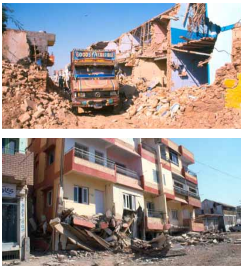
Εικ. 4 Απόψεις καταστροφών που έφτασαν τους XI E.M.S.-1998 στο ανερχόμενο τέμαχος του ανάστροφου ρήγματος Kachchh που ενεργοποιήθηκε κατά τον σεισμό της 26 ης Ιανουαρίου 2001.
