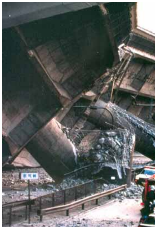
Εικ. 10 Απόψεις του ρήγματος Nojima που ενεργοποιήθηκε κατά τον σεισμό του Hanshin της 17 ης Ιανουαρίου 1995 (πάνω) και εντυπωσιακή κατάρρευση της υπερυψωμένης οδικής αρτηρίας (κάτω) στο Kobe η οποία ήταν θεμελιωμένη κατά μήκος του ρήγματος.
