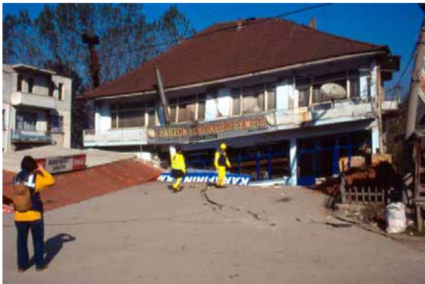
Εικ. 16 Υποχώρηση οικοδομής μέσα στο έδαφος σε περιοχή ανάπτυξης flower structure κατά μήκος της NAFZ κατά το σεισμό της 12 ης Νοεμβρίου 1999.
