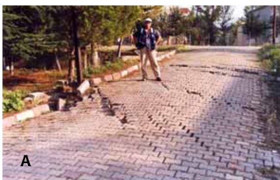
Εικ. 14 Η ανάπτυξη της pull apart basin κατά μήκος της NAFZ στην περιοχή του Golcuk της Τουρκίας. Στις φωτογραφίες (κάτω) διακρίνονται τμήματα του σεισμικού ρήγματος στα όρια του βυθίσματος ( LEKKAS, 2003 ).
