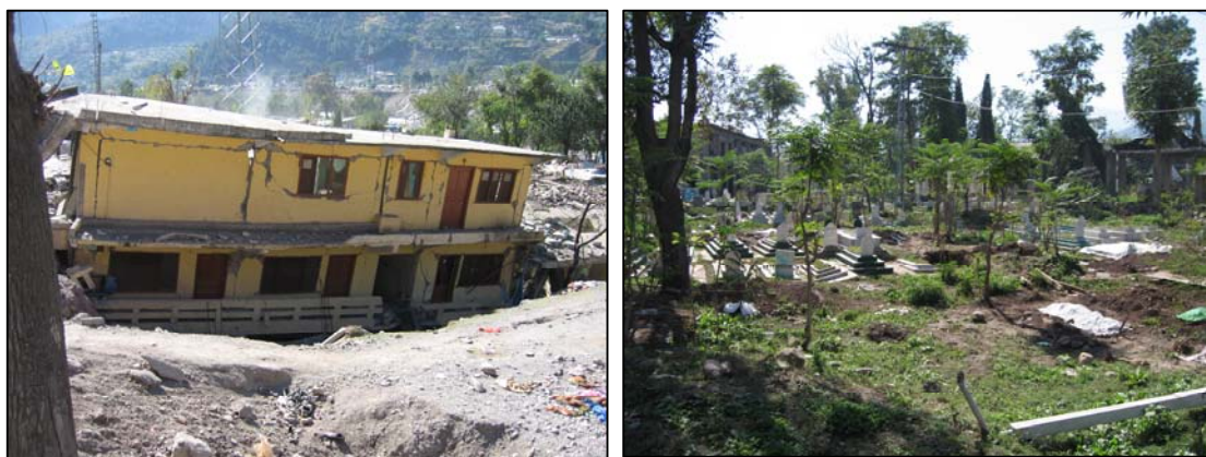
Εικ. 16. Κατάρρευση κτιρίου στη Balakot λόγω αστοχίας του εδάφους θεμελίωσης και εμφανείς εδαφικές μεταβολές στο κοιμητήριο της πόλης Muzaffarabad.
