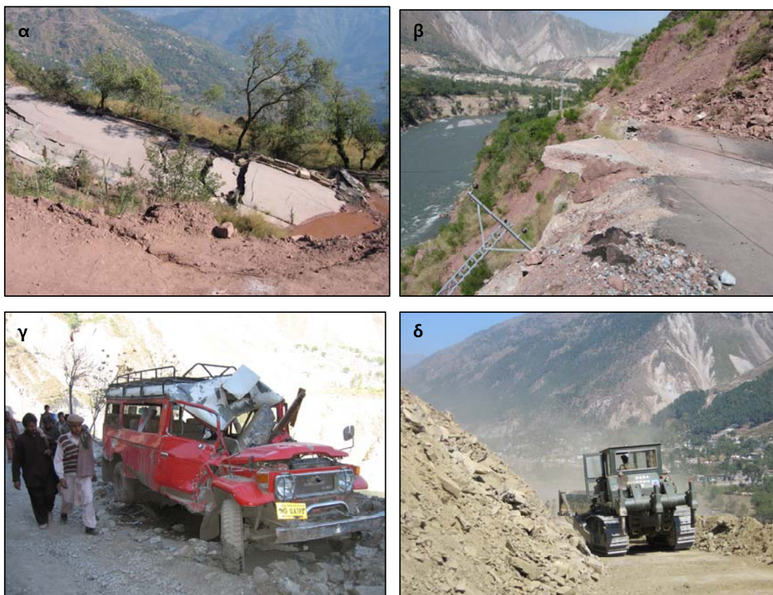
Εικ. 13. Κατολίσθηση που παρέσυρε το οδόστρωμα του οδικού άξονα Islamabad – Muzaffarabad (α), κατολισθήσεις κατά μήκος του οδικού δικτύου που οδηγεί στο βόρειο Κασμίρ (β), χαρακτηριστική περίπτωση κατάπτωσης βραχώδους όγκου σε οδικό άξονα βόρεια του Muzaffarabad (γ) και προσπάθεια διάνοιξης δικτύου από στρατιωτικές δυνάμεις (δ).
