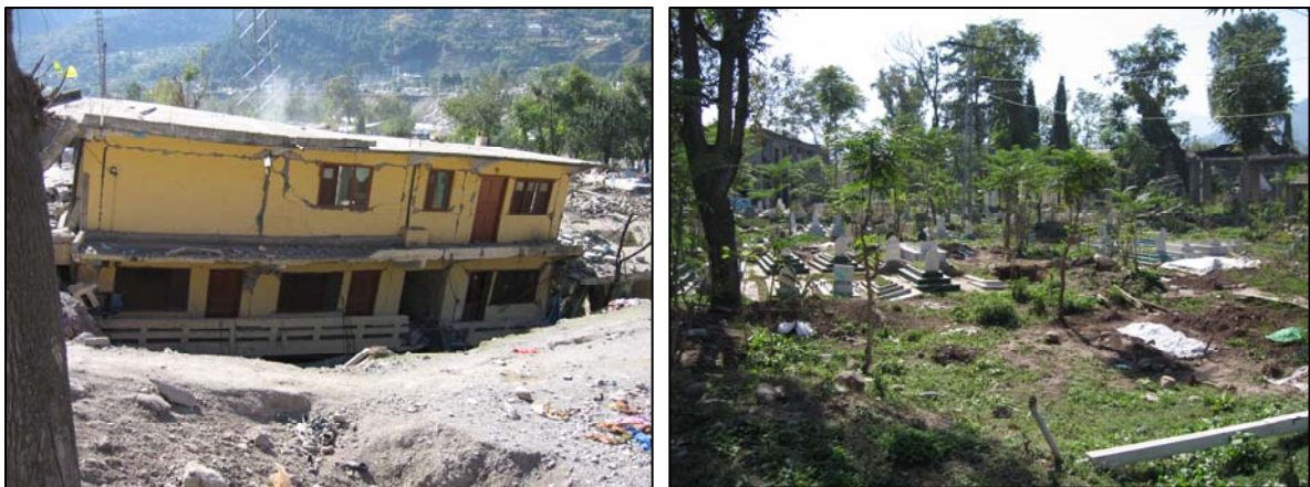
Εικ. 16. Κατάρρευση κτιρίου στη Balakot λόγω αστοχίας του εδάφους θεμελίωσης και εμφανείς εδαφικές μεταβολές στο κοιμητήριο της πόλης Muzaffarabad.
