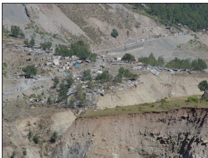
Εικ. 14. Ολοκληρωτική καταστροφή οικισμού βόρεια του Muzaffarabad που είναι θεμελιωμένος σε κώνο κορημάτων.
