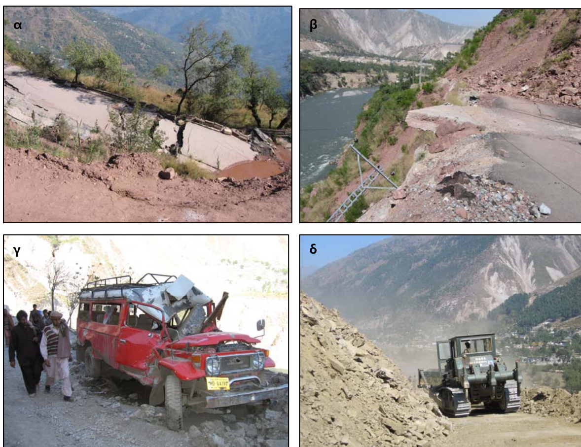
Εικ. 13. Κατολίσθηση που παρέσυρε το οδόστρωμα του οδικού άξονα Islamabad – Muzaffarabad (α), κατολίσθησεις κατά μήκος του οδικού δικτύου που οδηγεί στο βόρειο Κασμίρ (β), χαρακτηριστική περίπτωση κατάπτωσης βραχώδους όγκου σε οδικό άξονα βόρεια του Muzaffarabad (γ) και προσπάθεια διάνοιξης δικτύου από στρατιωτικές δυνάμεις (δ).
