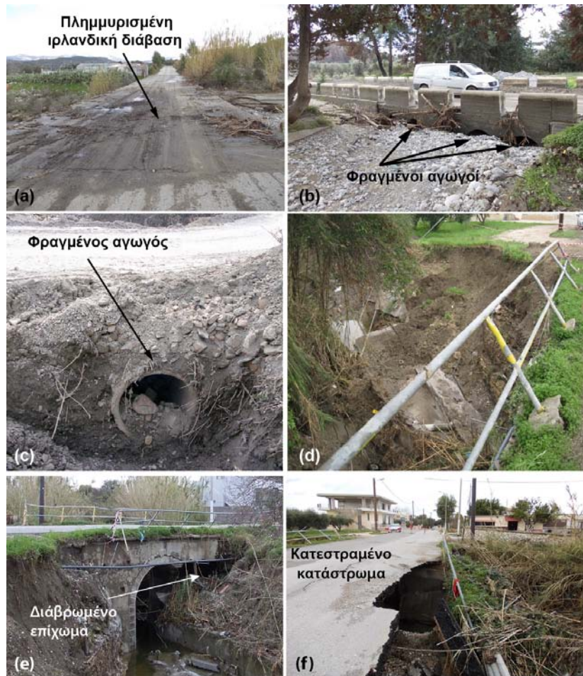
Εικόνα 7. Τύποι επιπτώσεων στις διαβάσεις του υδρογραφικού δικτύου, όπως (a) πλημμυρισμένες ιρλανδικές διαβάσεις, (b, c) φραγμένοι αγωγοί, (d) γκιγκλιδώματα και άλλες εκτασταστάσεις που έχουν καταρρεύσει, (e) διαβρωμένες επιχωματώσεις και (f) κατεστραμμένα καταστρώματα γεφυρών και οδών.
