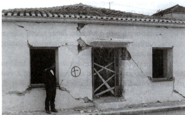
Εικ. 3: Καταγραφή Κωδωνοστασίου εκκλησίας και μεγάλες ζημιές σε κατασκευές με οπτοπλινθοδομή, οι οποίες προκλήθηκαν από το σεισμό.
