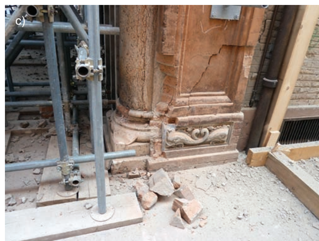
Fig. 26. The Mirandola Town hall; a) no major damage is noted by a rapid optical survey from the exterior, except the damage shown in b) and c) at the bottom of the masonry columns due to impact. Il Municipio di Mirandola; a) da un rapido esame visivo dall'esterno non si notano gravi danni, ad esclusione di quelli mostrati in b) e c) alla base delle colonne in muratura, in seguito a impatto.
