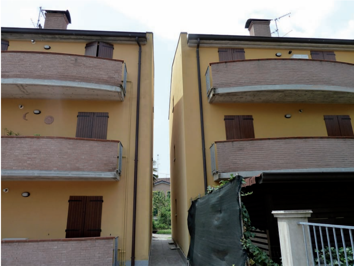
Fig. 16. Rigid body motion of two neighbouring buildings that tilted one against the other. The buildings did not show other apparent damage. Moto rigido di due edifici confinanti, che si sono inclinati uno verso l'altro. Gli edifici non mostrano segni apparenti di danni.
