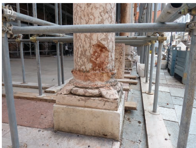
Fig. 26. The Mirandola Town hall; a) no major damage is noted by a rapid optical survey from the exterior, except the damage shown in b) and c) at the bottom of the masonry columns due to impact. Il Municipio di Mirandola; a) da un rapido esame visivo dall'esterno non si notano gravi danni, ad esclusione di quelli mostrati in b) e c) alla base delle colonne in muratura, in seguito a impatto.
