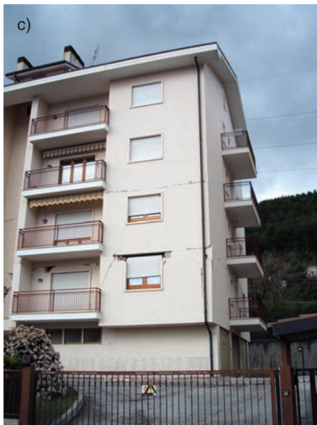
Fig. 30. a) Additional vibrational effects on floors and roofs from the vertical earthquake component. Usually in most cases, the walls above the floor or roof level are toppling inside the building. This means that the fall is due to upwards motion of the supports (perimetric walls); b) and c) Damages observed in Pettino (L'Aquila) after the 2009 Earthquake a) Effetti delle vibrazioni sui solai e le coperture, a causa della componente verticale del sisma. Nella maggior parte dei casi, i muri al di sopra del livello del solaio o del tetto ricadono all'interno del perimetro dell'edificio. Ciò significa che la caduta è dovuta al moto verso l'alto degli appoggi (muri perimetrali); b) e c) danni osservati a Pettino (L'Aquila) dopo il terremoto del 2009.
